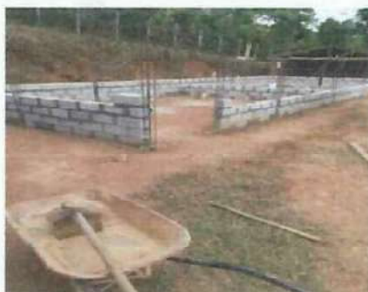
Foto 5: Se observa la falta los balcones.
